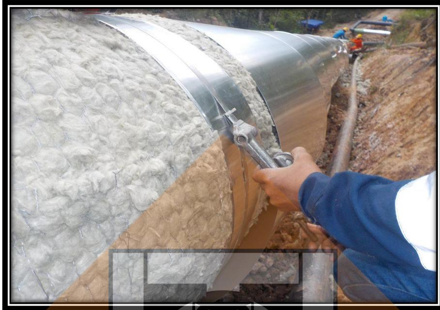
**Gambar 2.5** Penggantian Isolator Pada Pipa Uap Panas
