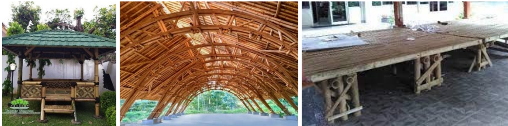
Gambar 4. Saung dengan struktur bambu (kiri), struktur atap dengan bambu (tengah) dan struktur lantai bambu untuk mitigasi bencana (kanan).
