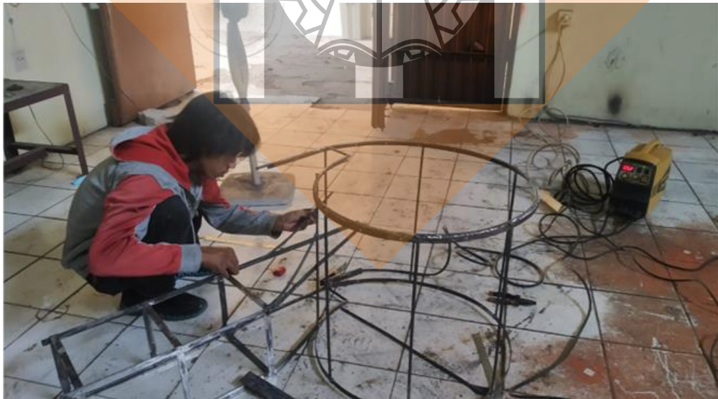
Gambar 2 Proses Pembuatan Saluran Masuk Air
