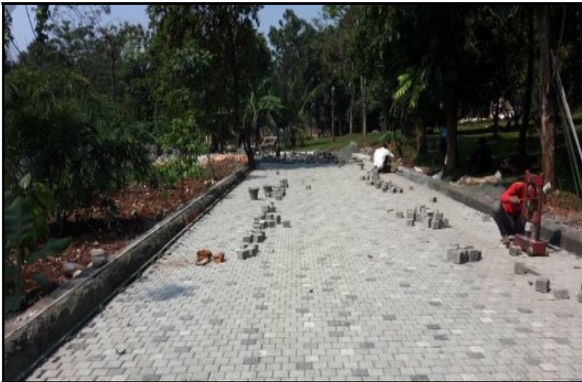
Gambar 2.3. Perawatan Celah / Joint yang terisi pasir secara baik meningkatkan kededapan air pada konstruksi Interblock.
