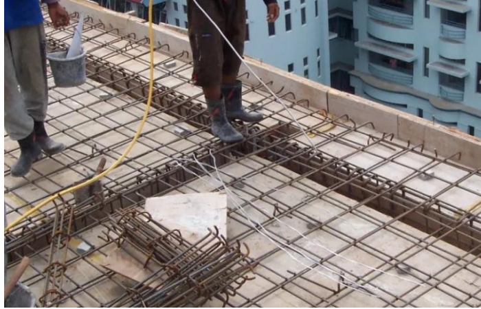
Gambar 5. 11 Struktur Atap Dak Beton
