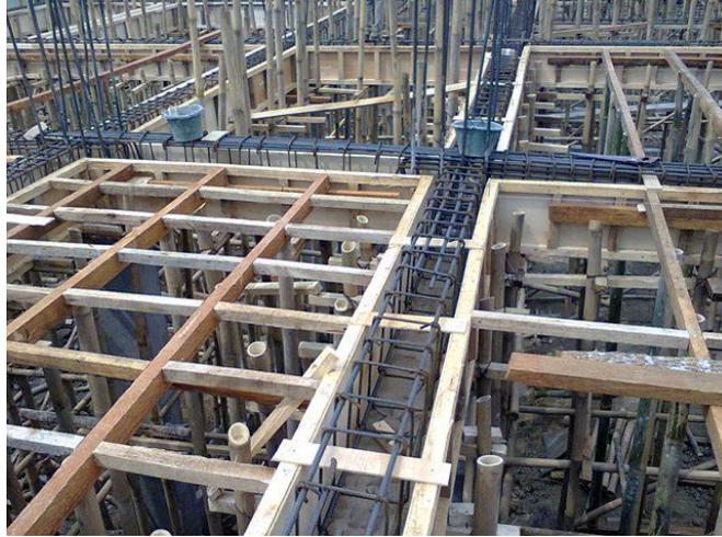
Gambar 5.14 Struktur Balok
