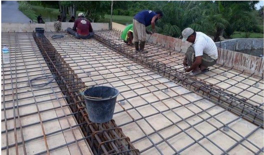
Gambar 5.16 Struktur Plat Lantai
