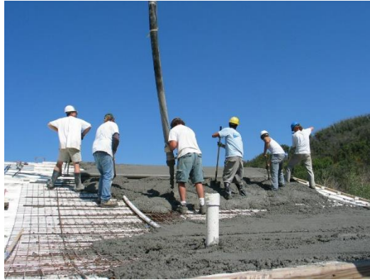
Gambar 5. 9 Struktur atap dak beton
