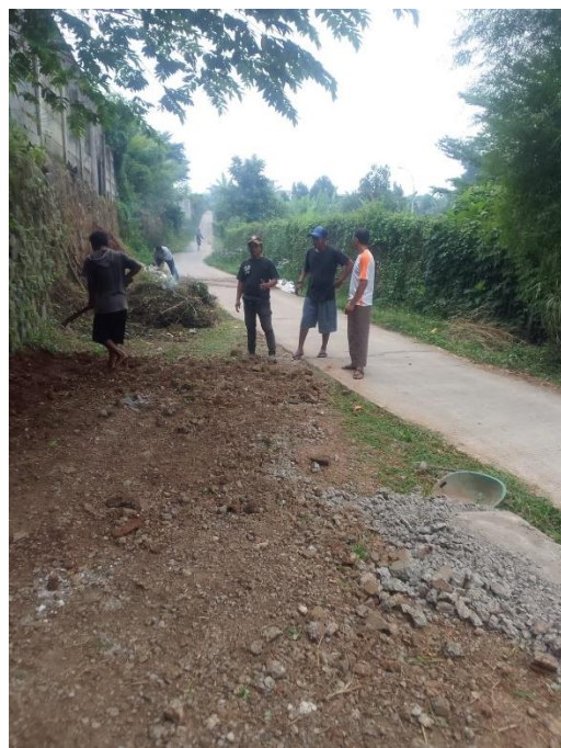
Gambar 9. Meratakan dasar tanah
