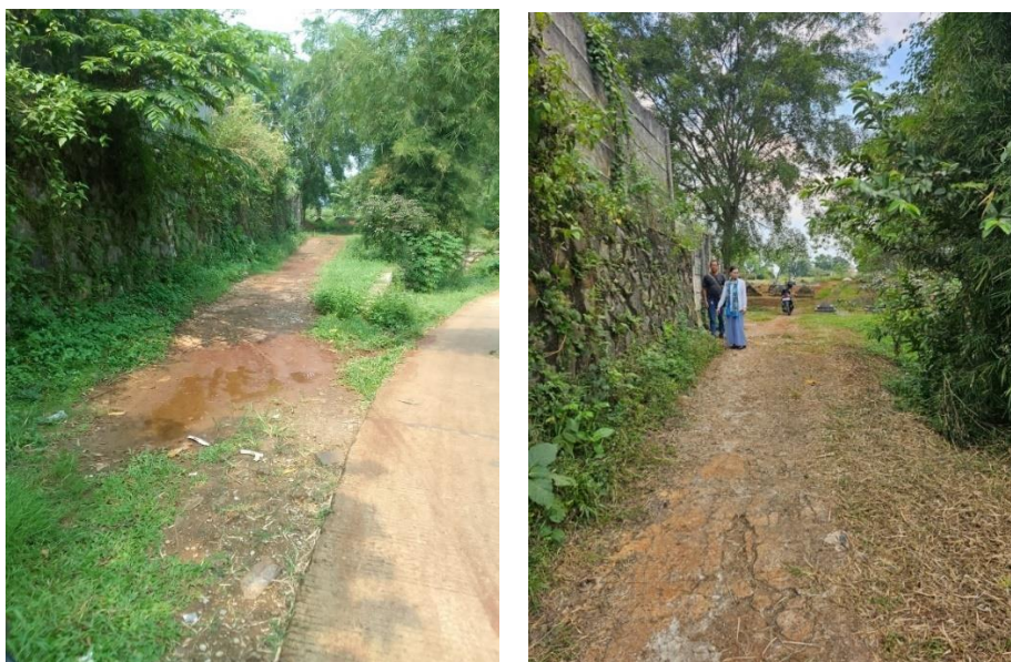
Gambar 1. Situasi Jalan Makam
