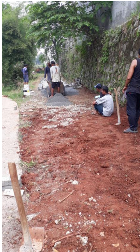
Gambar 10. Pemasangan lapisan dasar
