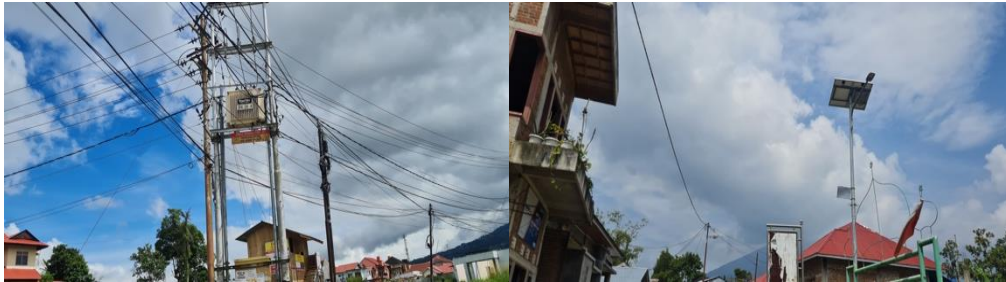
Gambar 4. 50 Dokumentasi Hasil Survei Kondisi Jaringan Listrik di WP Kawasan Perkotaan Banuhampu
