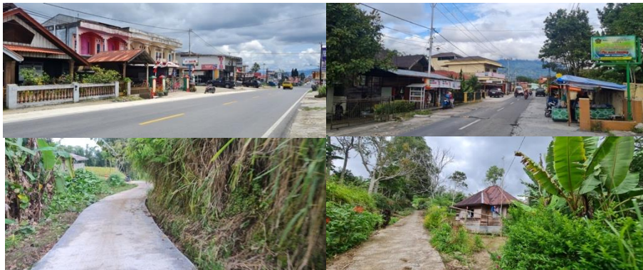
Gambar 4. 33 Dokumentasi Hasil Survei Kondisi Jalan di WP Kawasan Perkotaan Banuhampu
