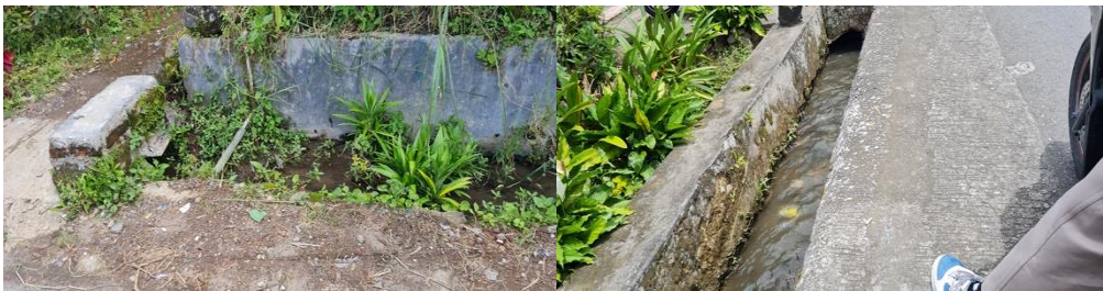
Gambar 4. 44 Dokumentasi Hasil Survei Kondisi Drainase di WP Kawasan Perkotaan Banuhampu
