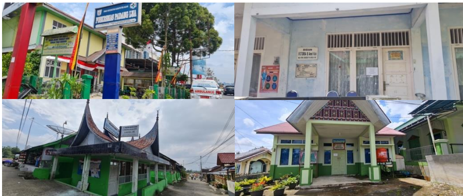
Gambar 4. 36 Dokumentasi Hasil Survei Kondisi Sarana Kesehatan di WP Kawasan Perkotaan Banuhampu
