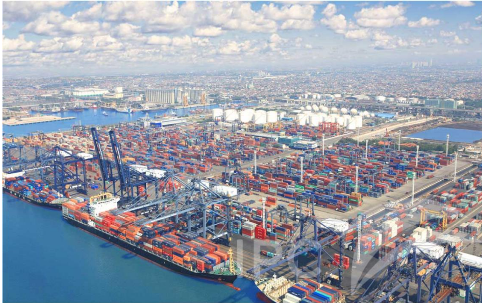
Gambar 1. 3 Pelabuhan Tanjung Priok, Jakarta Utara (IPC News – Pelindo)
