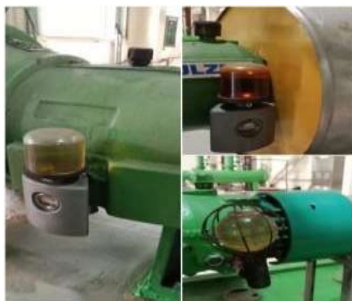
Gambar 4.2 Pengecekan pelumas mesin
