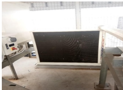
Gambar 2.9 Kondensor wongso tipe WAC -070 (Dokumentasi PT Agung Segar Teknik)
