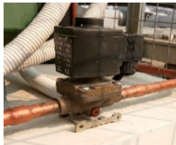
Gambar 2.18 Solenoid valve (Dokumentasi PT Agung Segar Teknik)
