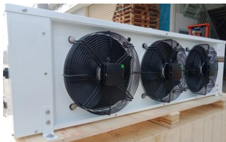
Gambar 2.11 Evaporator tipe WDD -7.5 (Dokumentasi PT Agung Segar Teknik)
