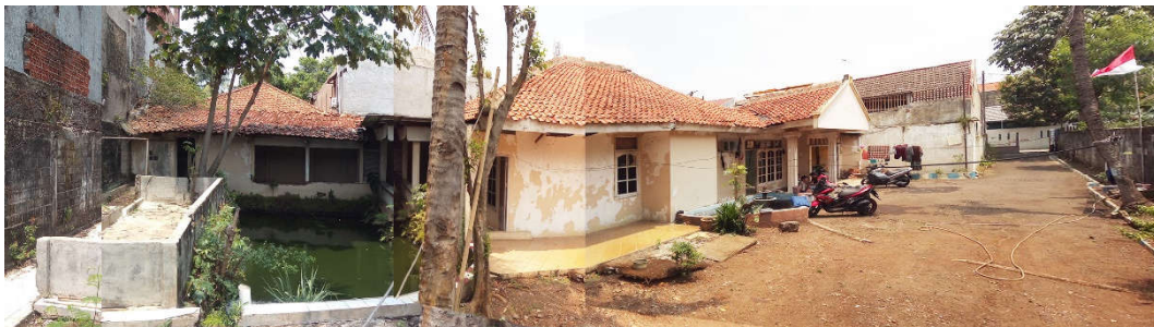
Gambar 2.2 Kondisi Bangunan Eksisting dalam Tapak
