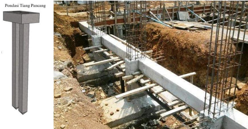
**Gambar 5.6.** Gambar Konsep Perencanaan Struktur Bawah Bangunan
