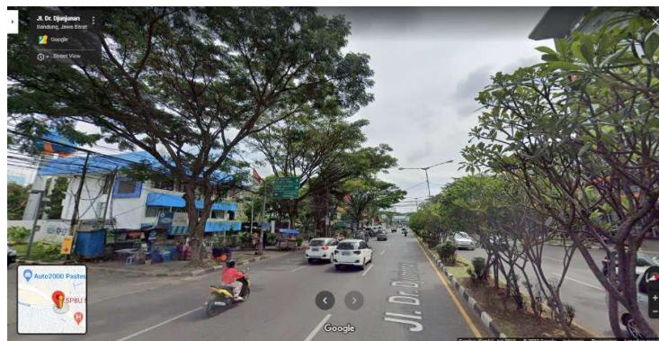
Gambar 7. Jl. Dr. Djunjunan (Pasteur) Sumber: Google Maps, 2019
