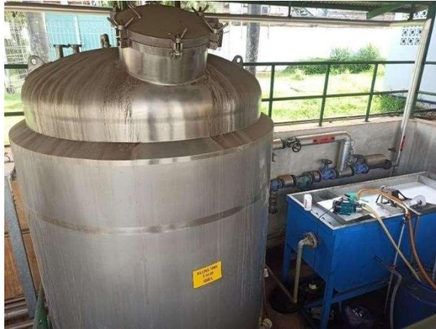
Gambar 2. 8 Killing Tank System dan Coalescer Plate untuk Pemisahan Minyak
