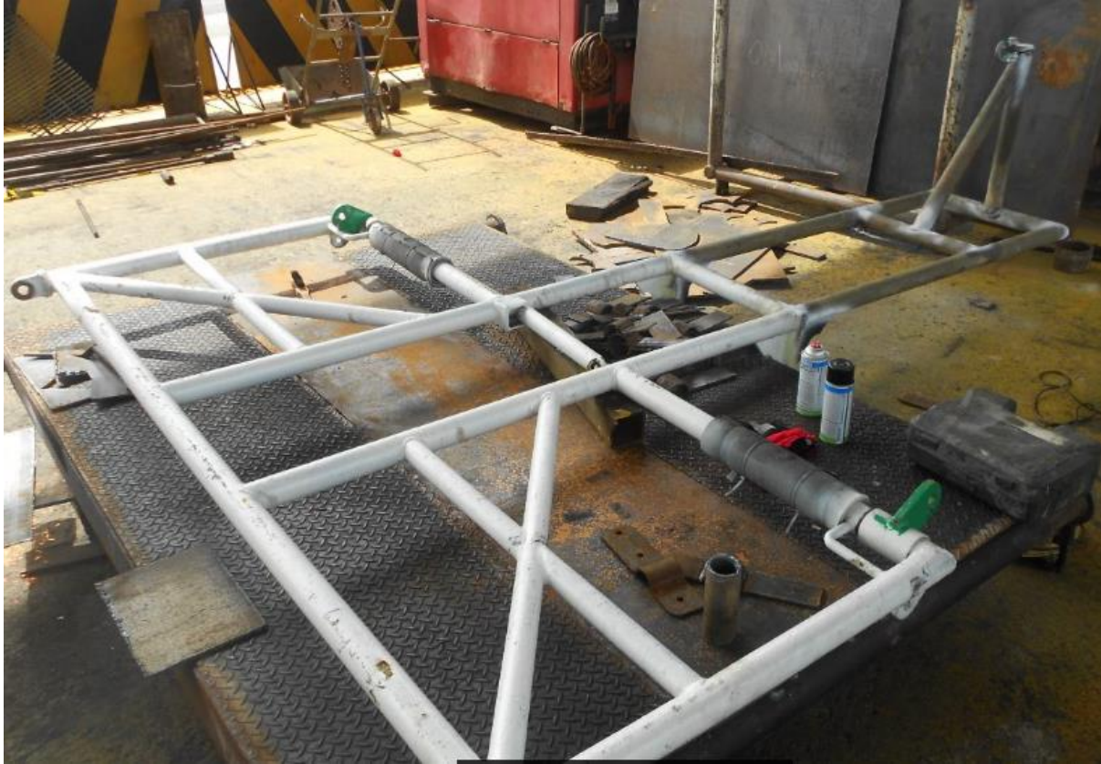
Gambar 5.4 Alat pelindung diri pekerja kontruksi dari kejatuhan yang telah selesai dibuat
