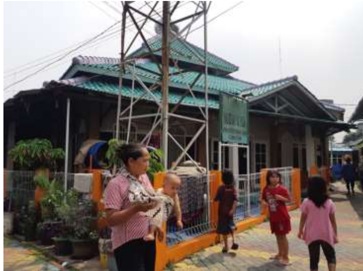
Gambar 4.9 : Kondisi Masjid di Kampung Bekelir
