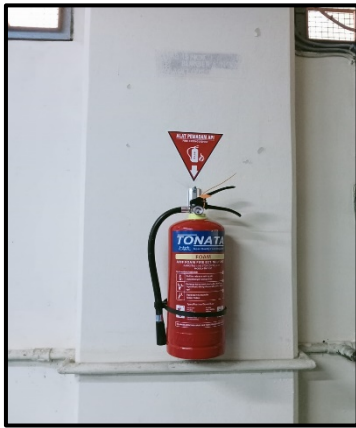
Gambar 8.3. Pemasangan APAR pada Laboratorium Teknik Kimia
