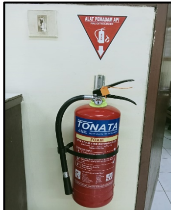
Gambar 8.3. Pemasangan APAR pada Laboratorium Teknik Kimia
