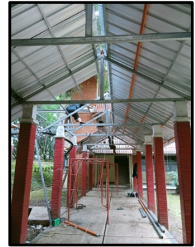
Gambar 8.4. Perbaikan atap penghubung selasar Gedung C, F dan G
