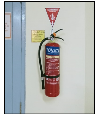
Gambar 8.3. Pemasangan APAR pada Laboratorium Teknik Kimia
