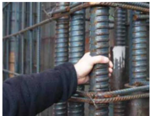
Gambar 13. Tulangan beton struktur bangunan.
