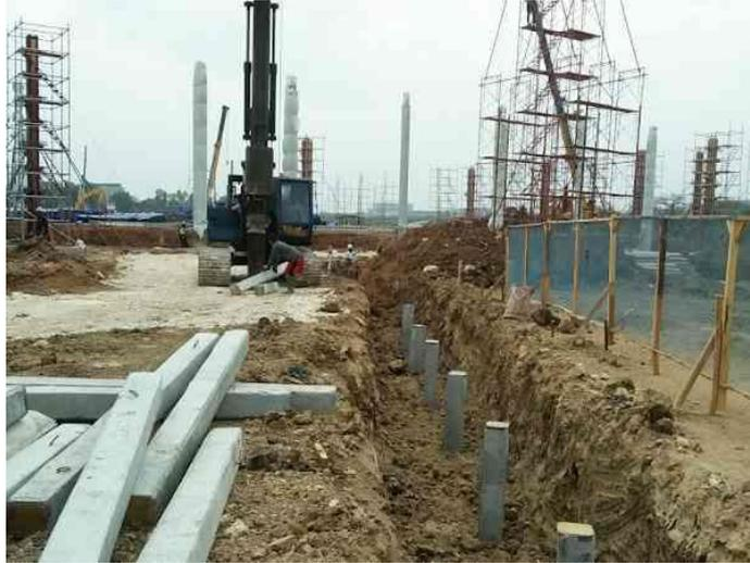
Gambar 5. 15 Pondasi Tiang Pancang Yang Sudah Ditancap Kedalam Tanah
