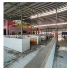
Pencahayaan alami dengan skylight
