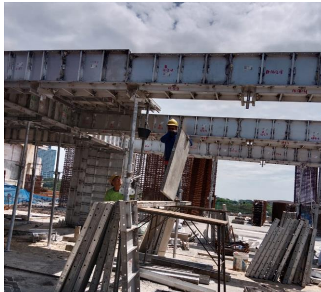
Gambar 1. 1 Bekisting Aluminium Pada Proyek Apartemen Kingland Avenue Tower The Fritz
