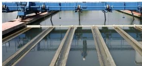
Gambar 4. 27 Bak penampung air bersih (BP-03)
