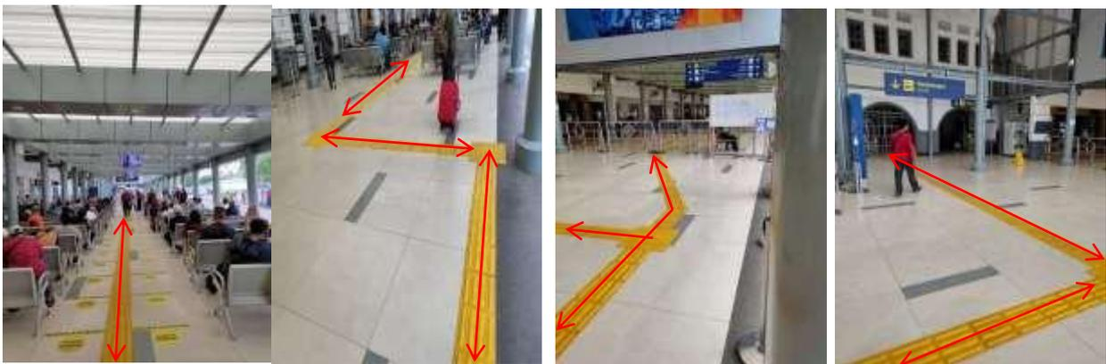
Gambar 4.14 Penempatan Guide block (Sumber : Hasil survey, 2021)
