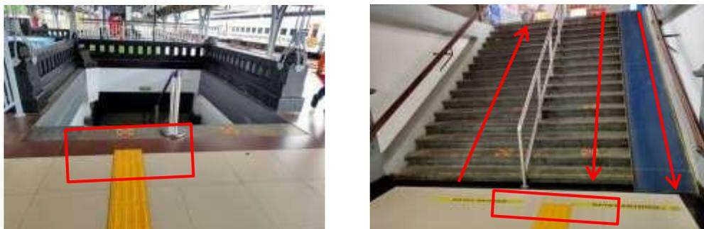
Gambar 4.17 Guide block di jalur tangga
