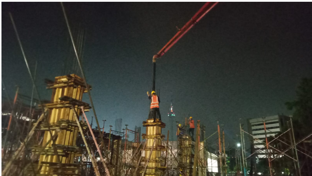
Gambar 4.7 Pengecoran tiang
