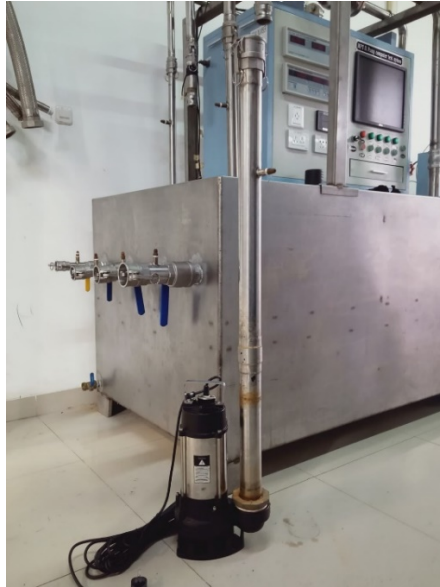
Gambar 4. 2 Proses Pemasangan Instalasi Pipa
