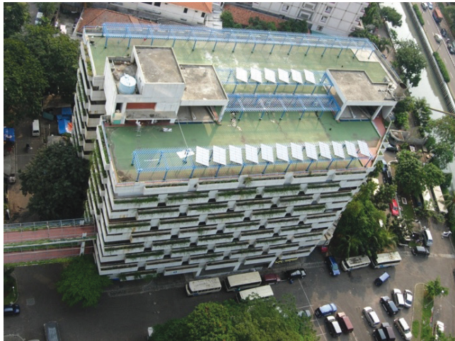
Pembangkit Listrik Tenaga Surya Sistem Grid connected di Gedung BPPT.
