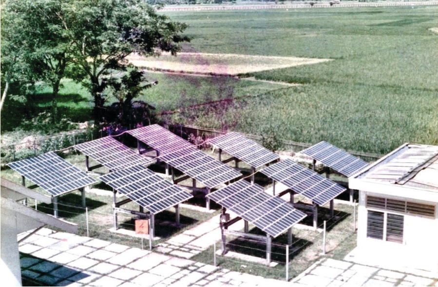
Pembangkit Listrik Tenaga Surya 5,5 kWp di Desa Surya Pertanian Picon. (sumber Chayun Budiyo "Laporan Desa Surya").
